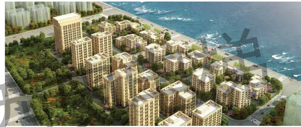
中交·东疆港区 CCG Dongjiang Port Area
