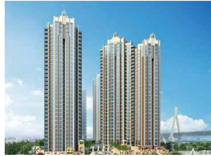
中交·江锦湾 CCG Jiangjin Bay
